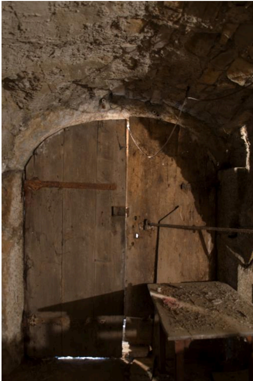
La porte de la cave, vue depuis l'intérieur
