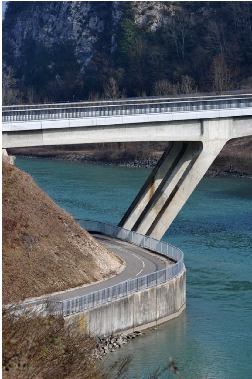
Vue partielle, béquille droite, face aval (depuis la rive droite)
