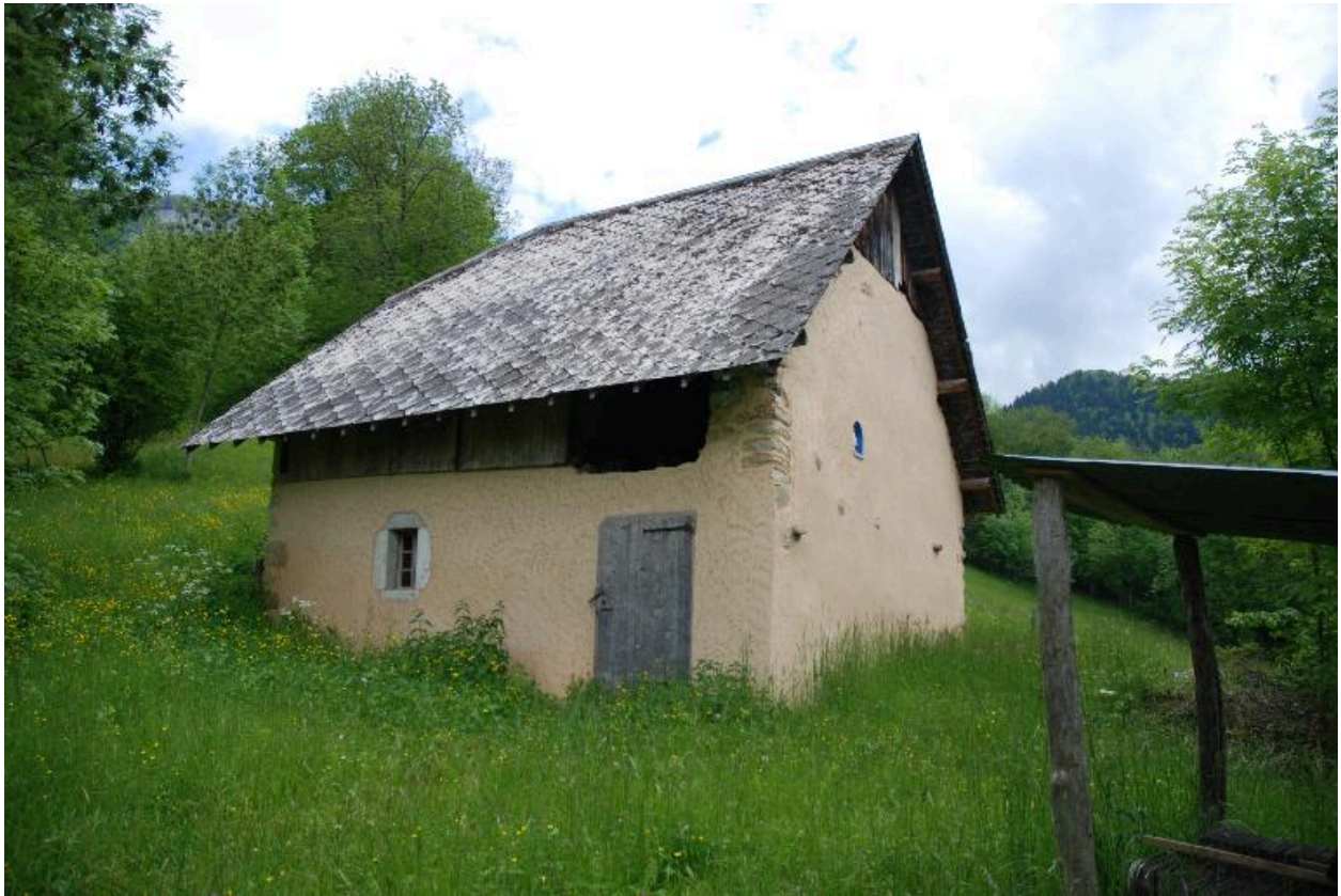
Ferme non repérée (2013 B4 423), façade principale.
