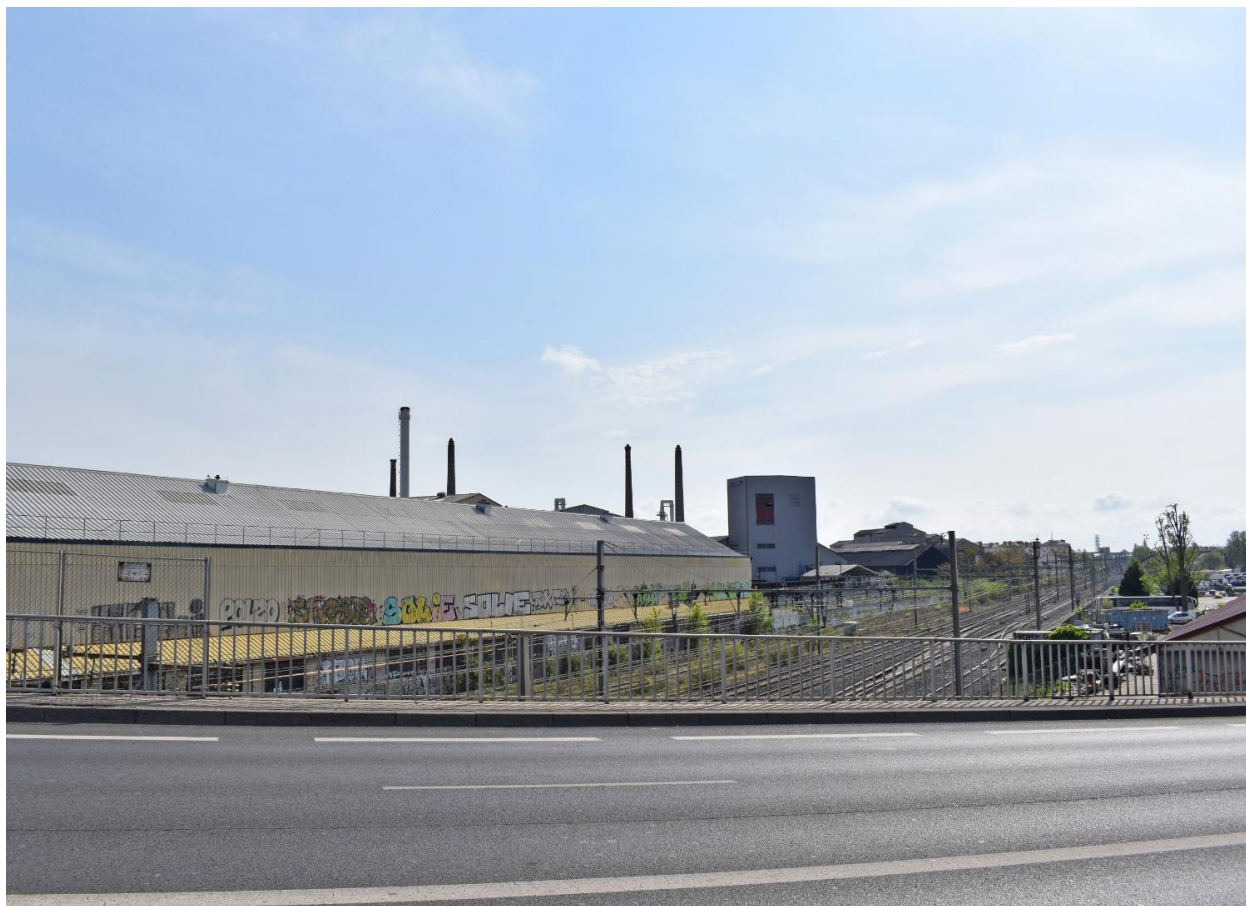
Aciéries de Longwy en 2022 vues depuis l'autopont
