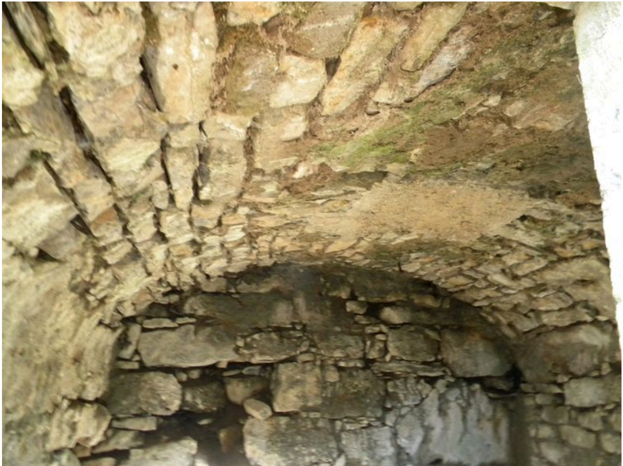
Vue de la cave d'une ancienne maison au Genièvre (2008 A1 17)
