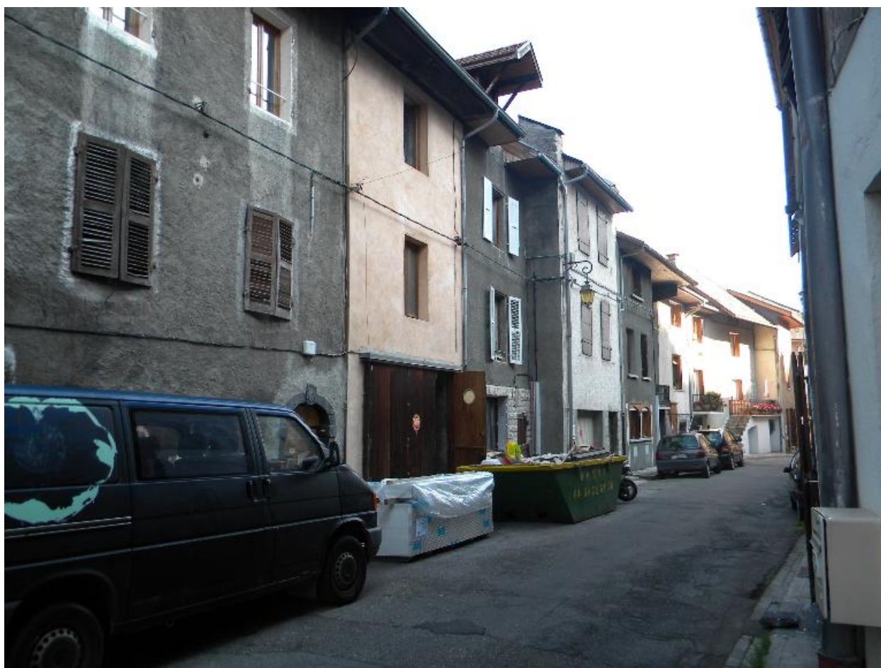
Façade de la rue Nicolas Blanc entre l'allée du Four et la rue Gambetta.
