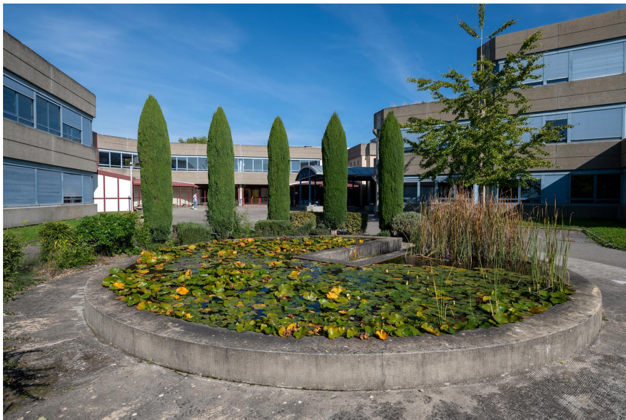
Installation extérieure : vue rapprochée en 2020
