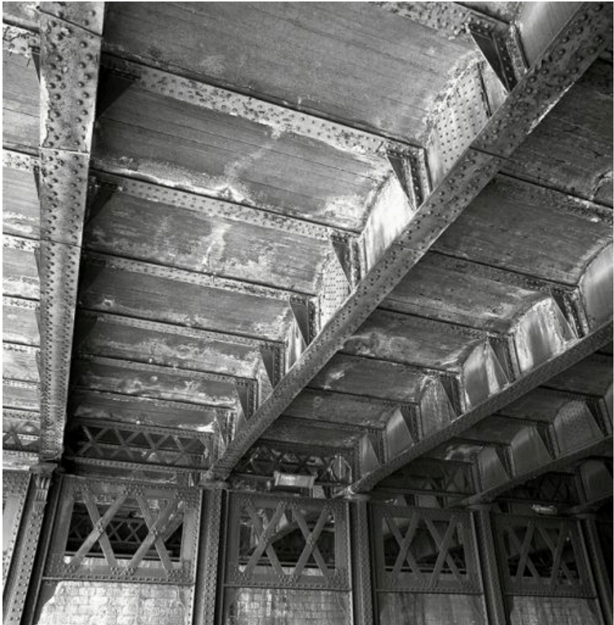
Travée de rive sur le quai Perrache : vue d'ensemble du dessous du tablier
