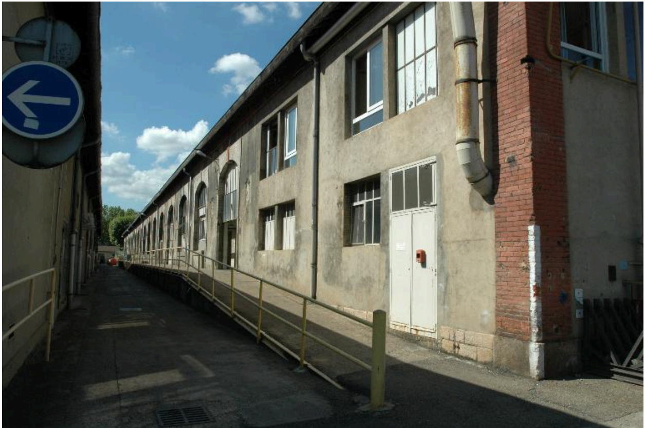
Vue extérieure des ateliers
