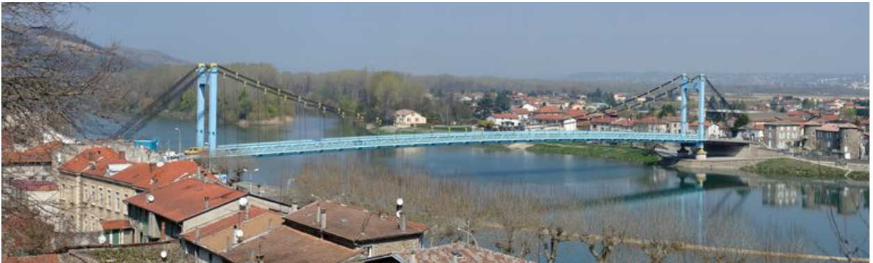
Vue panoramique, face aval (depuis Serrières, rive droite)
