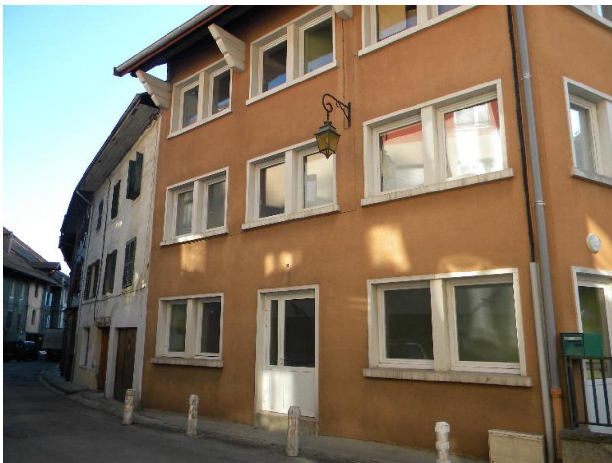
Alignement de façades dans la rue Nicolas Blanc au nord de l'église côté rocher (2008 D15 2740, 5369).
