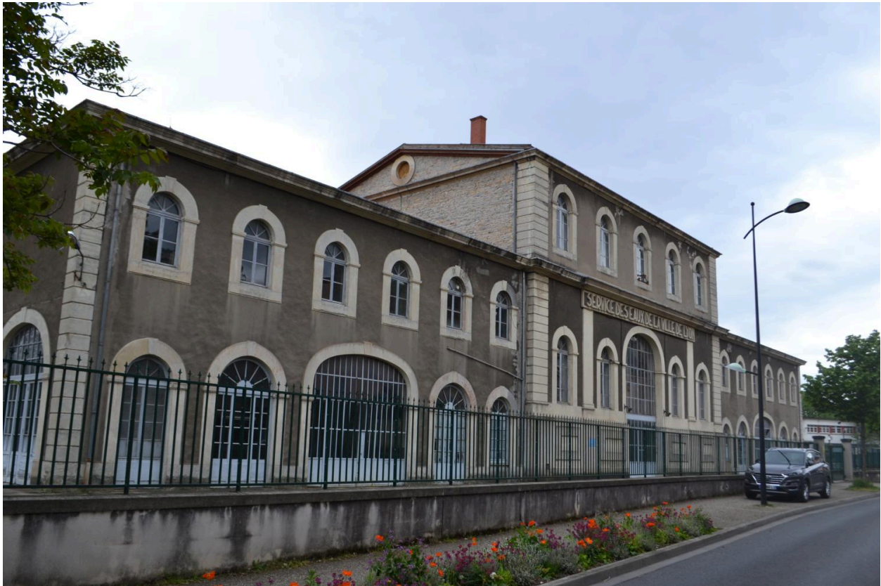
Vue d'ensemble du bâtiment principal
