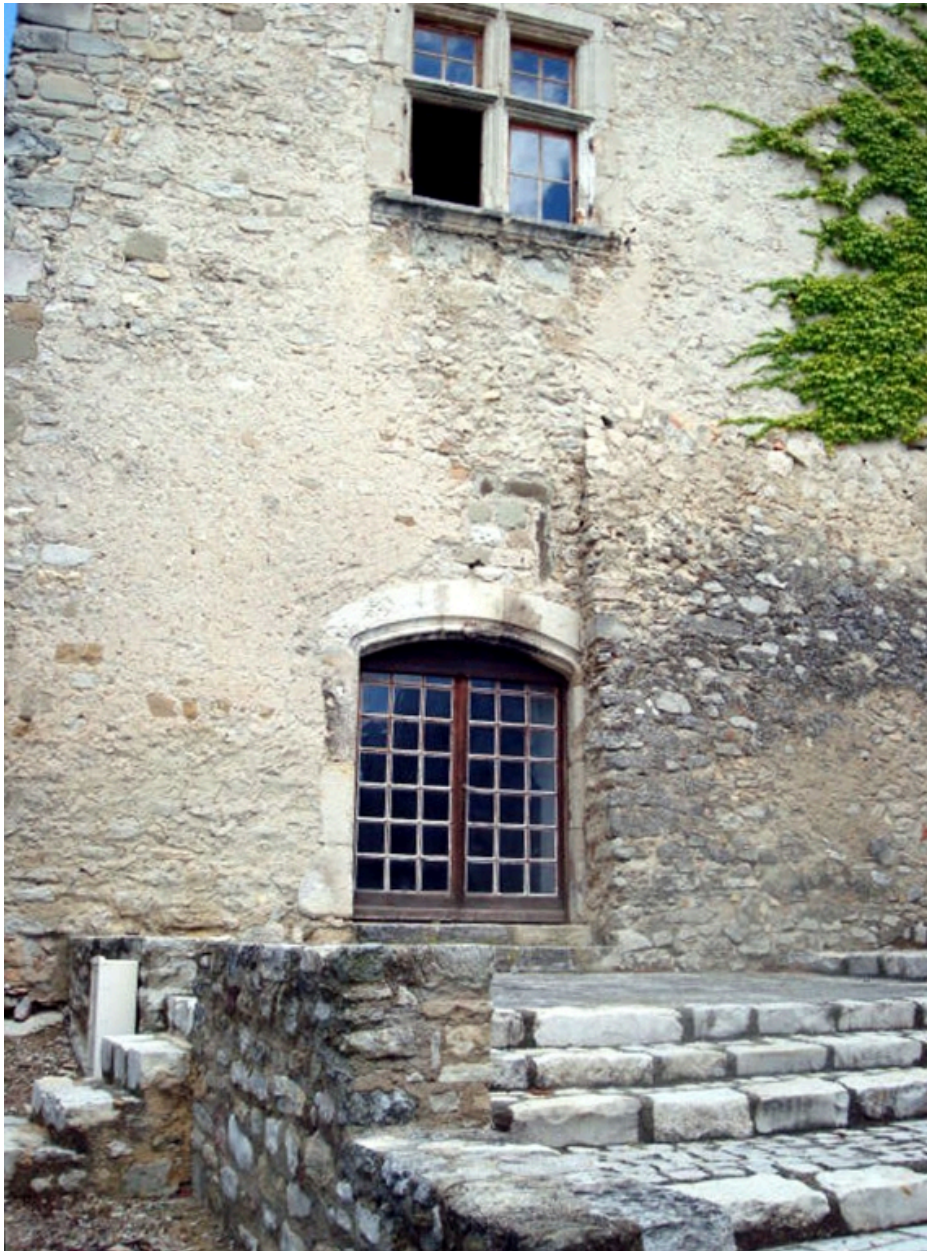
Vue partielle de l'élévation sud-ouest du corps de logis.
