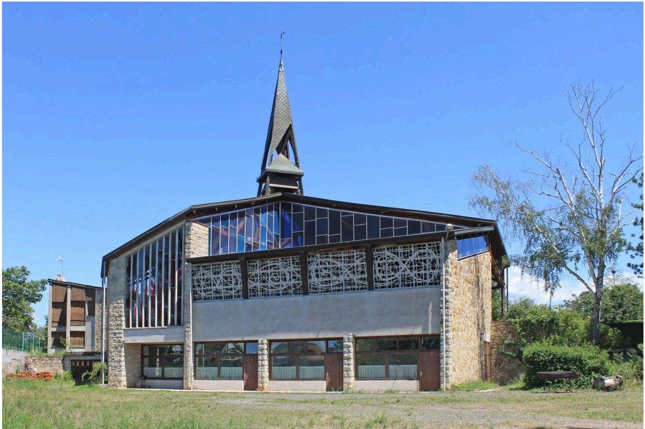
Brioude, chapelle de la Borie Darles, vue générale depuis le sud-ouest avec – à gauche – la façade ouest du logement.
