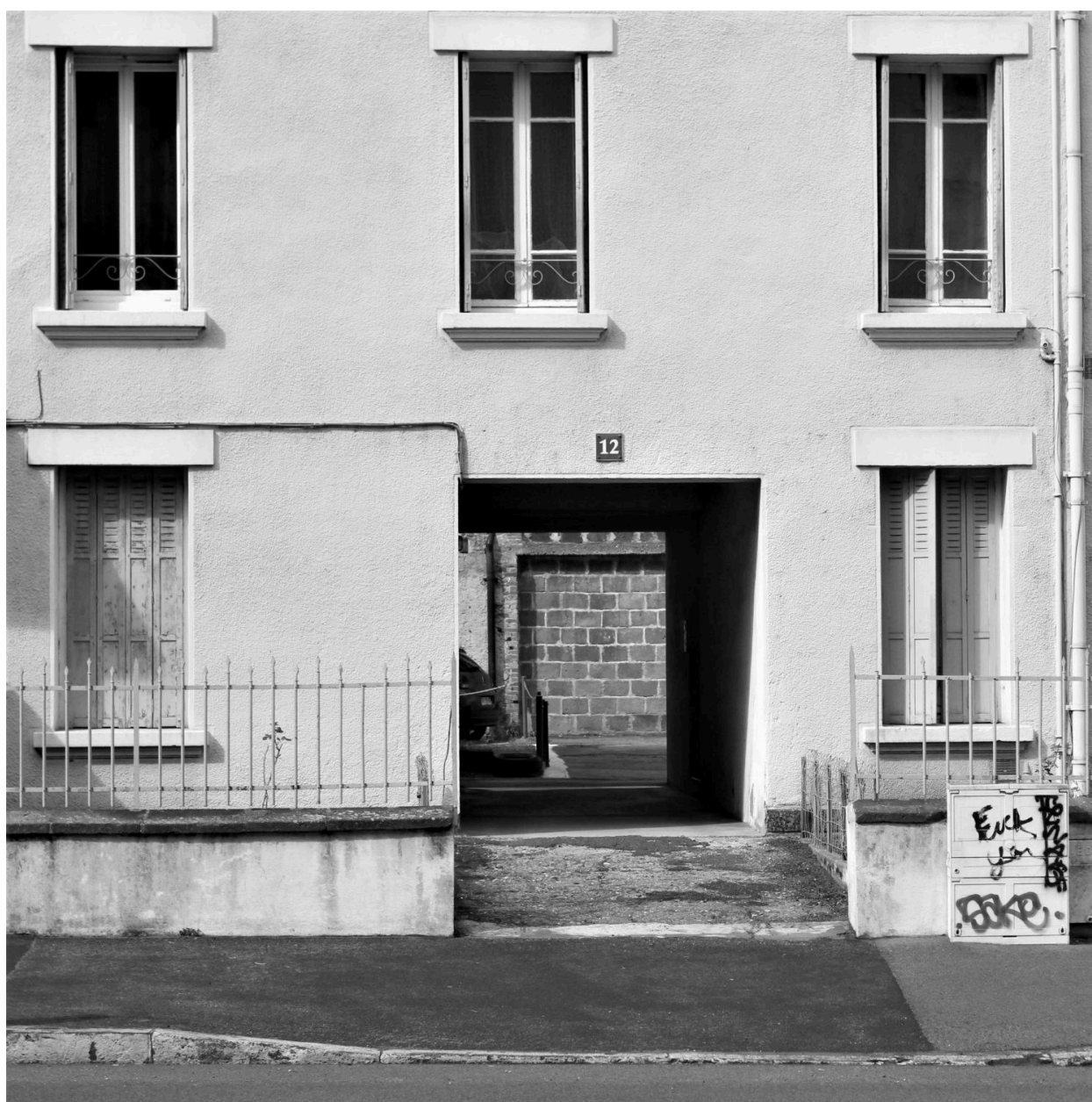
Entrée de l'immeuble du 12 boulevard Fleury
