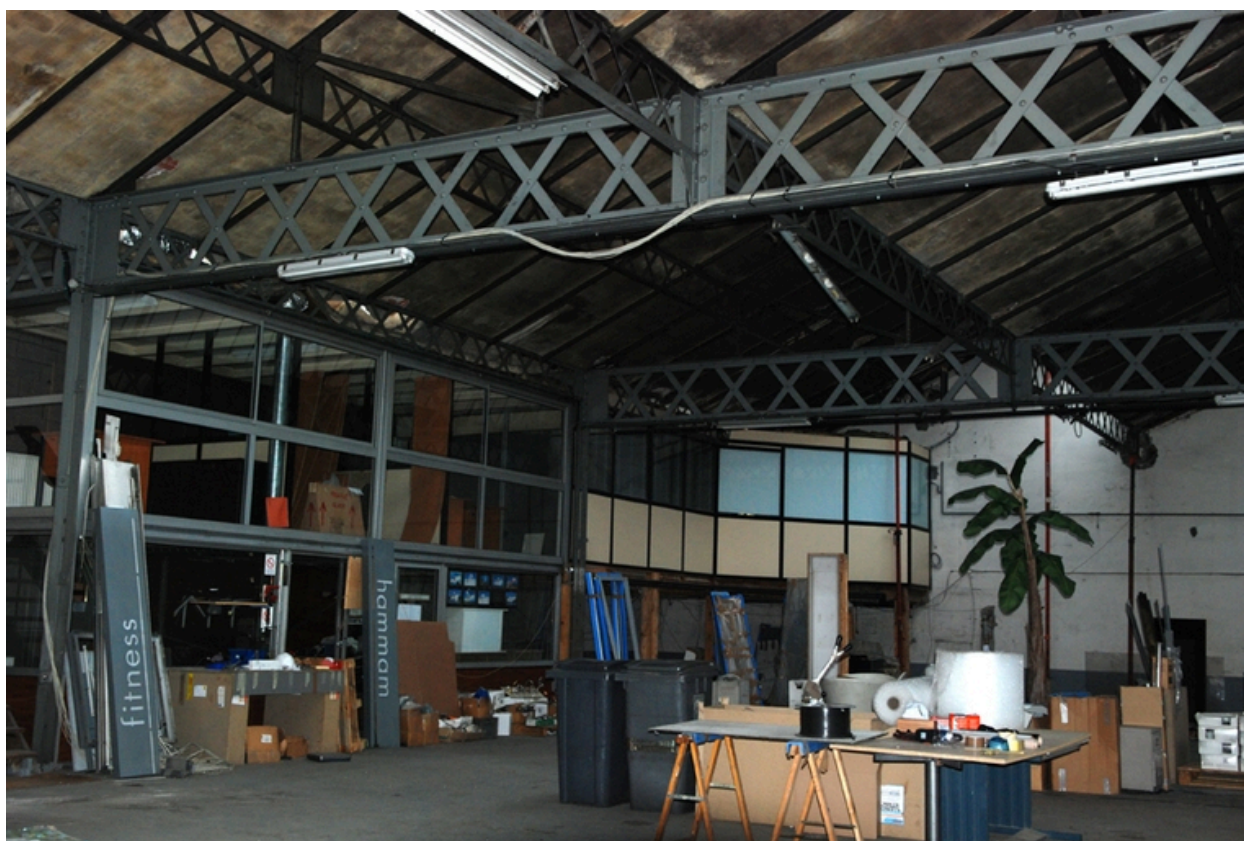
Vue d'ensemble des ateliers avec structure métallique en charpente
