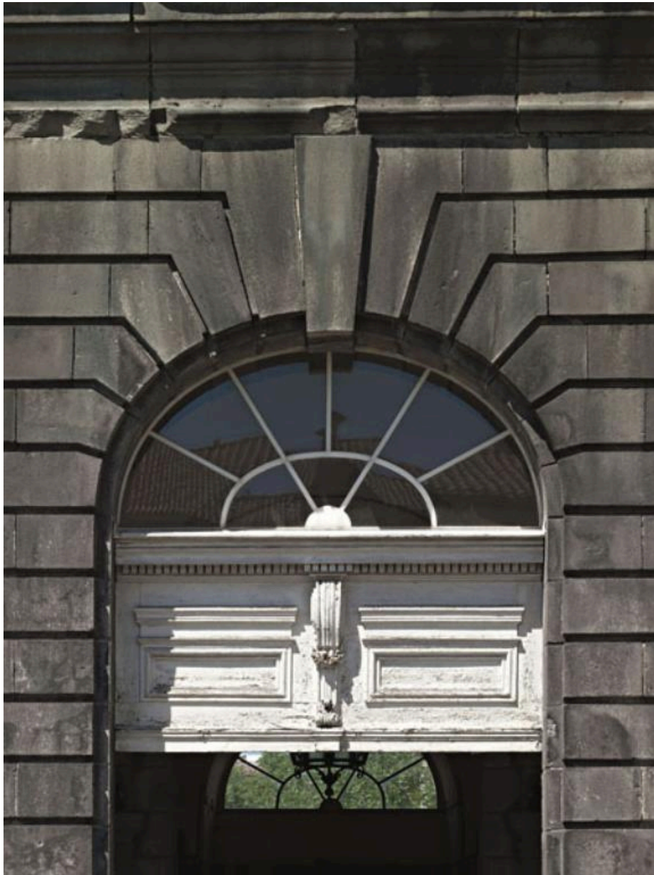
Hôtel-Dieu de Clermont-Ferrand. L'hôtel-Dieu, façade sud du corps de bâtiment nord, baie axiale du rez-de-chaussée, détail de l'arc segmentaire à extrados en escalier et clef pendante.
