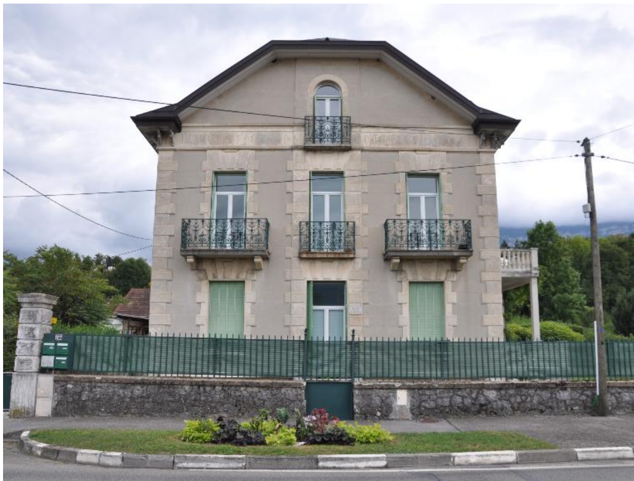
Façade latérale ouest
