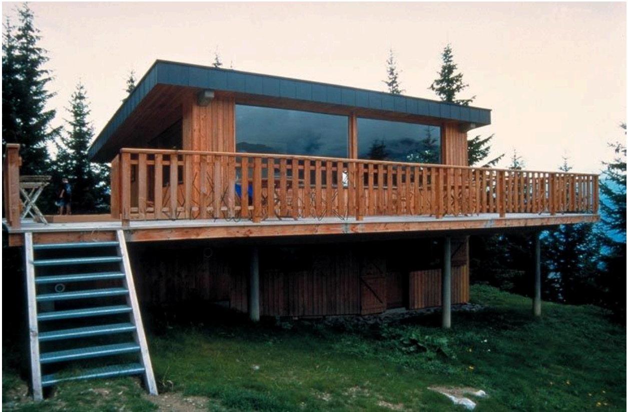
L'élévation sud et sa coursière
