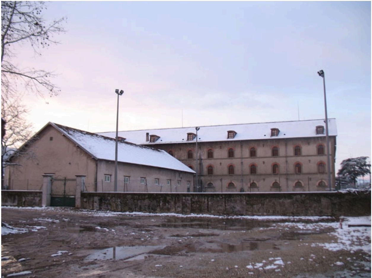
Vue sud de l'aile sud et d'un entrepôt
