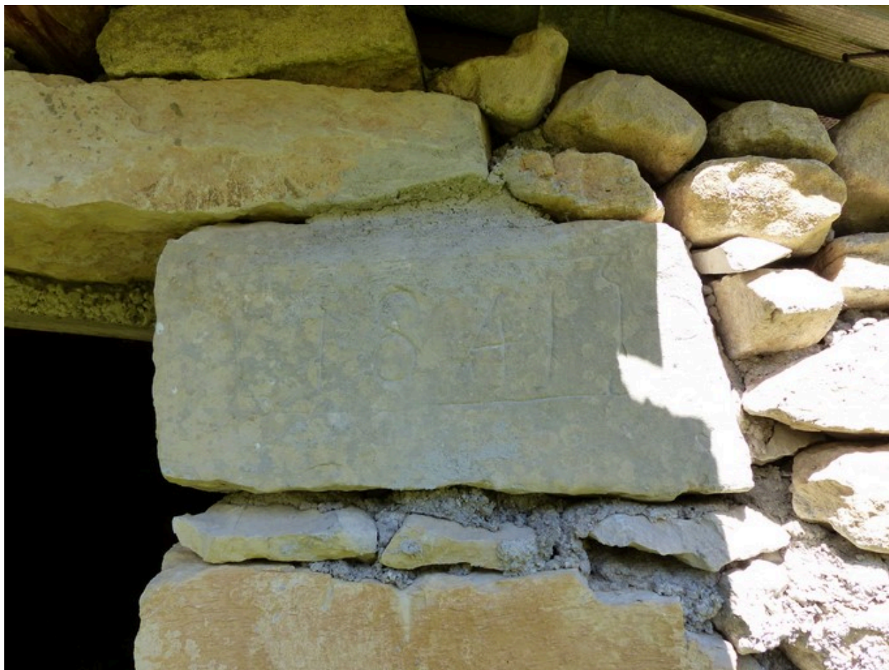
Pignon est, date portée (1841).
