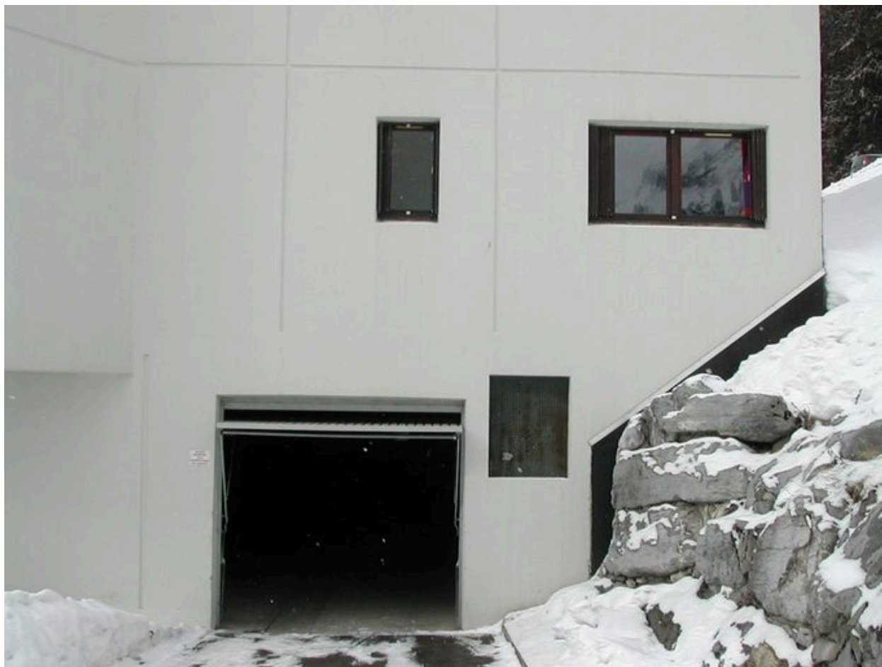
Entrée des garages, façade nord
