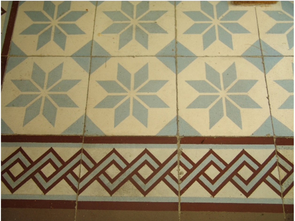
Appartement du 1er étage, sol en carreaux de ciment, détail
