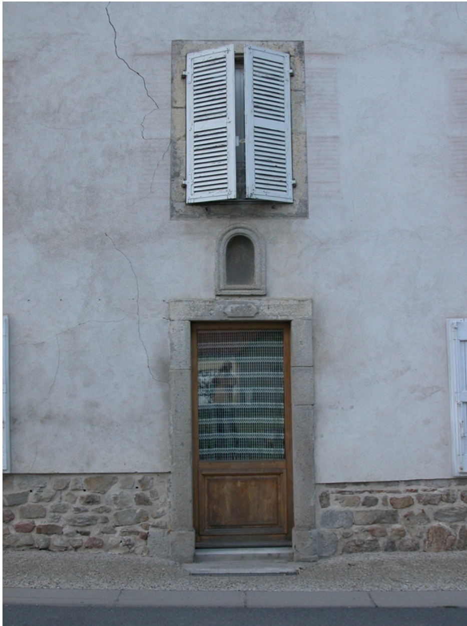
Détail de la façade du logis.
