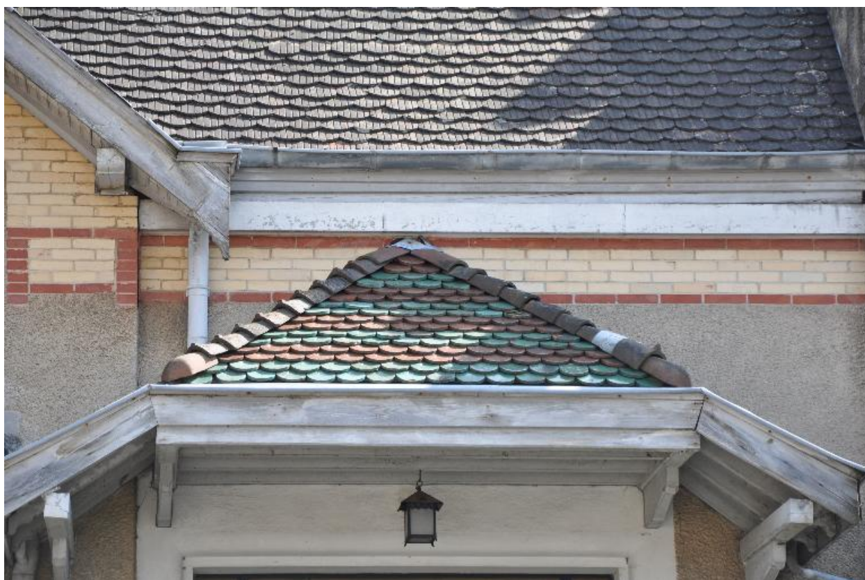
Tuiles en écailles vernissées de l'auvent
