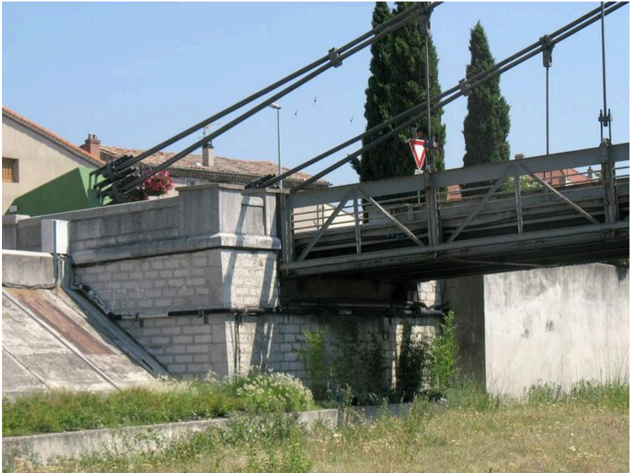
Vue de la culée rive droite (côté La Voulte)
