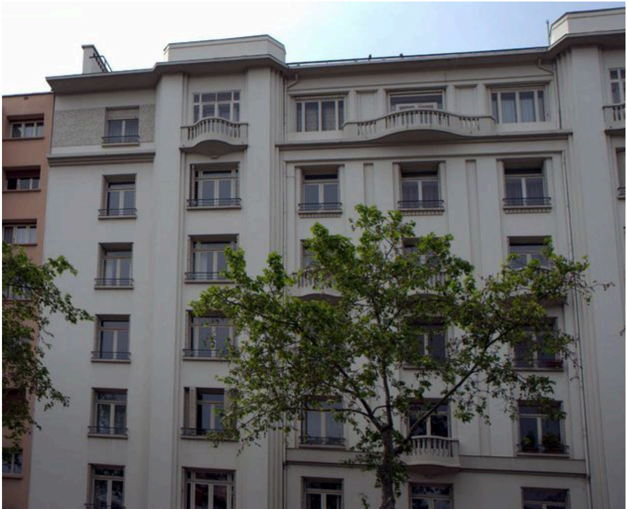
Elévation principale, vue partielle
