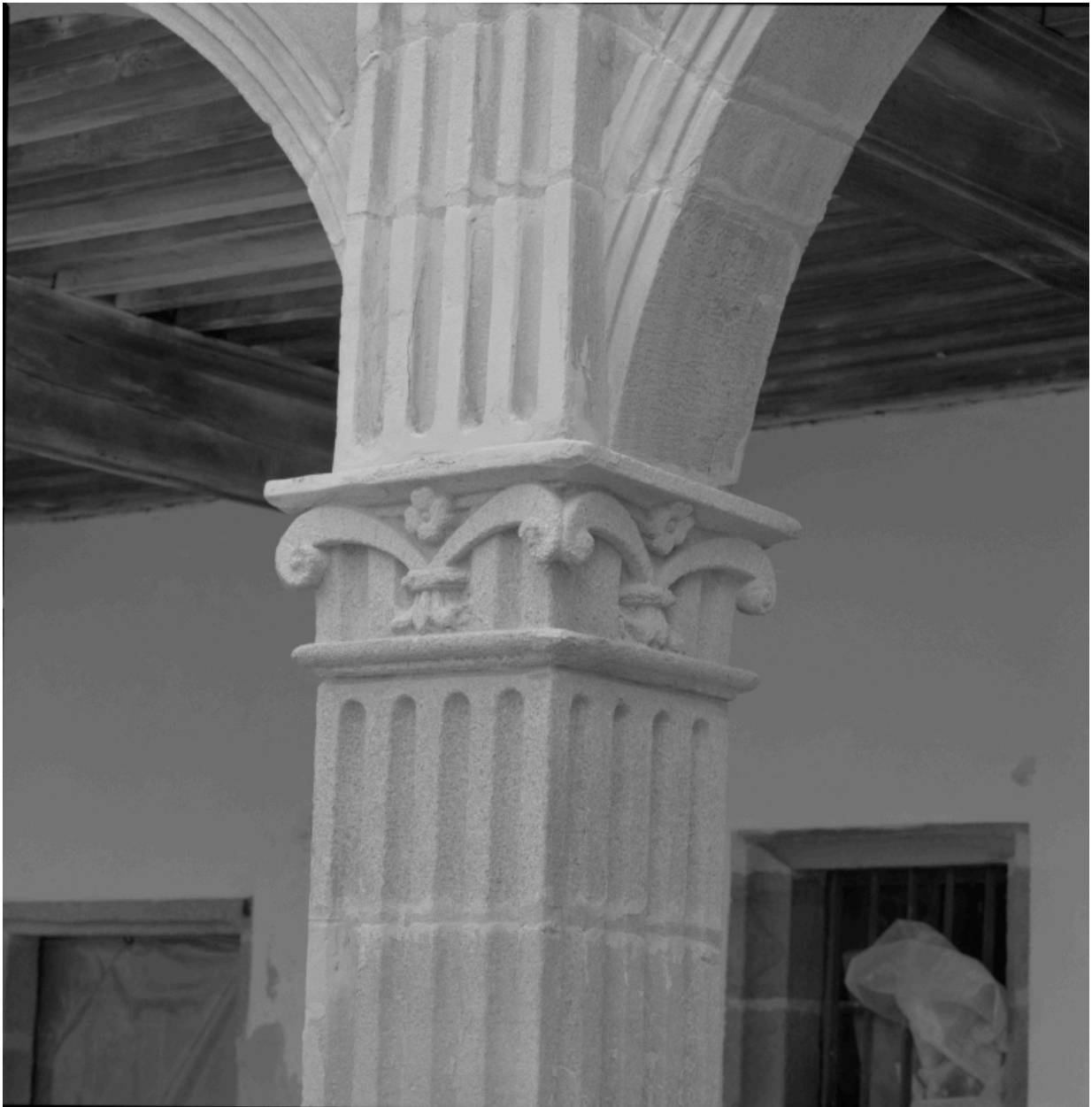
Corps de galerie : de droite à gauche, détail du 2e chapiteau bas du portique.
