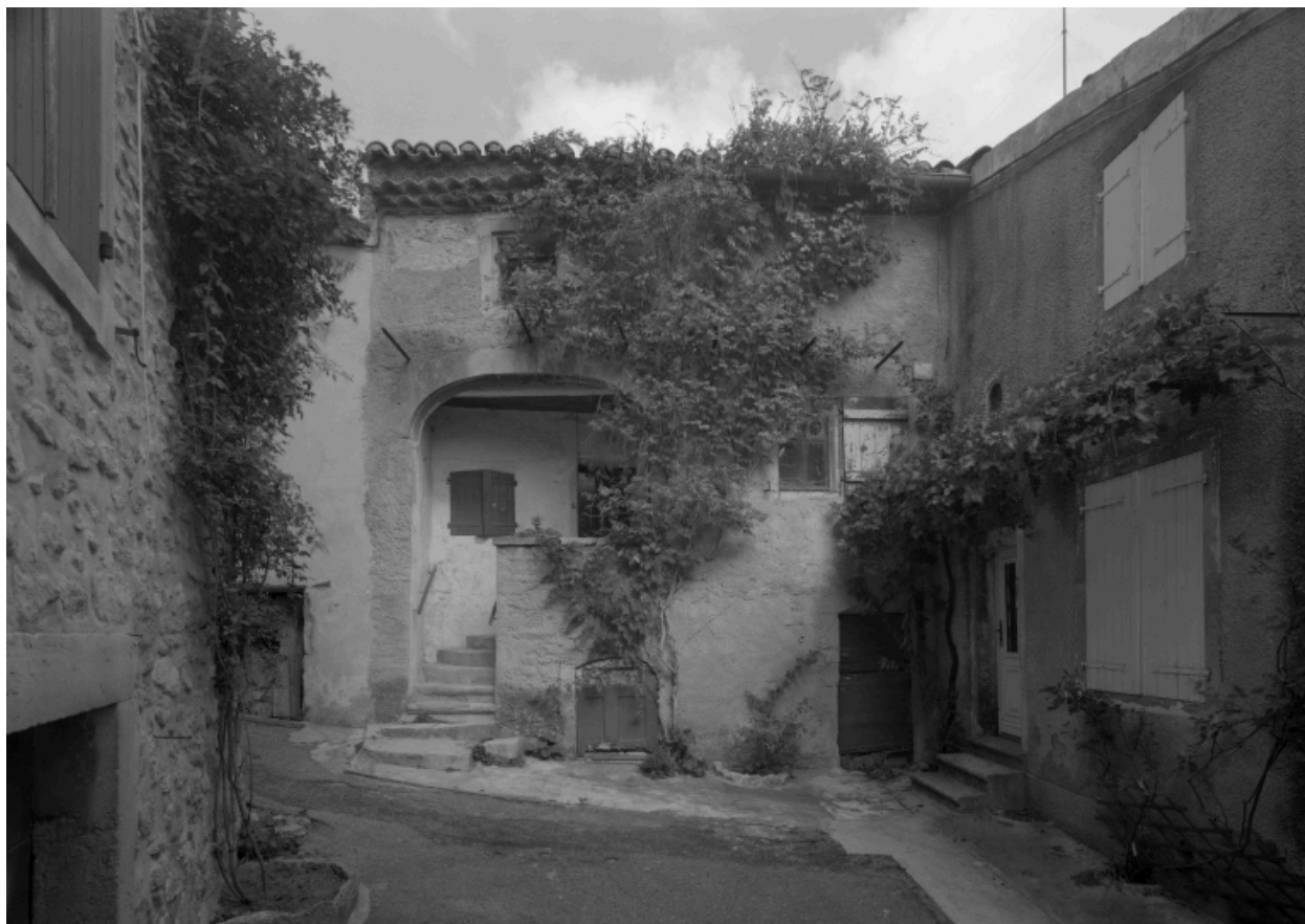
Rue de Coste-Froide. Maison de type II (D2 975).
