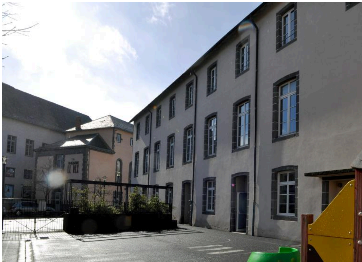
Corps de bâtiment est : élévation postérieure, depuis le nord
