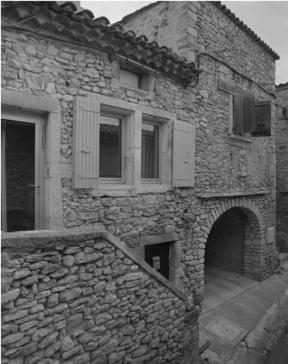
Façade sur la Grand'rue, en cours de restauration.
