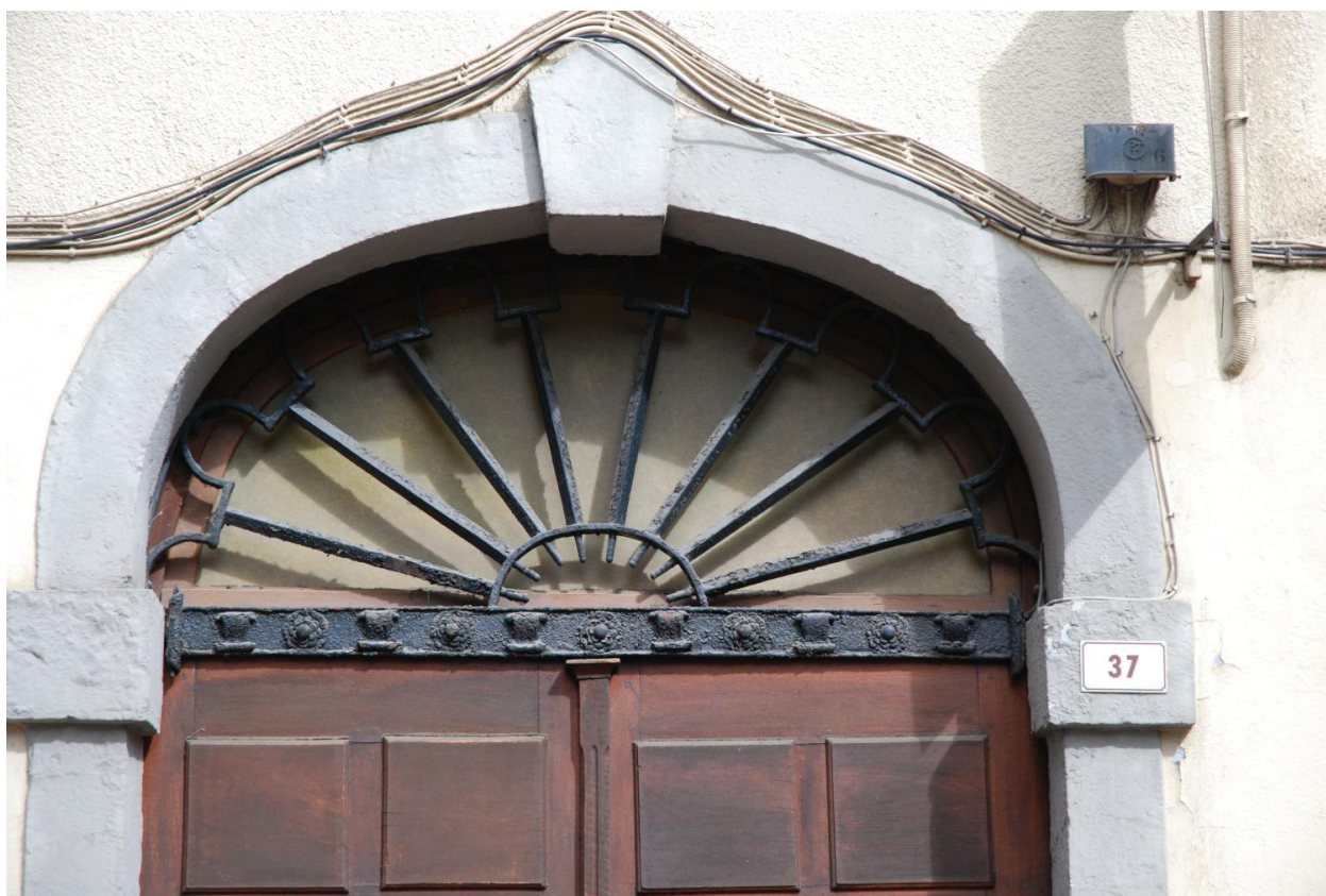
Détail de l'imposte en fer forgé.
