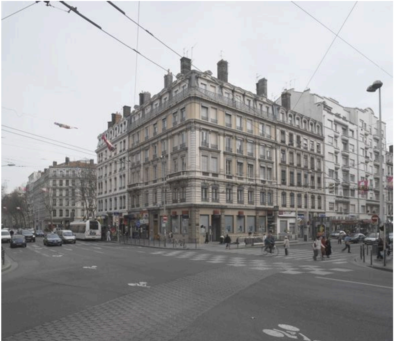
Vue générale des façades cours Gambetta et avenue Jean-Jaurès, depuis le nord-est
