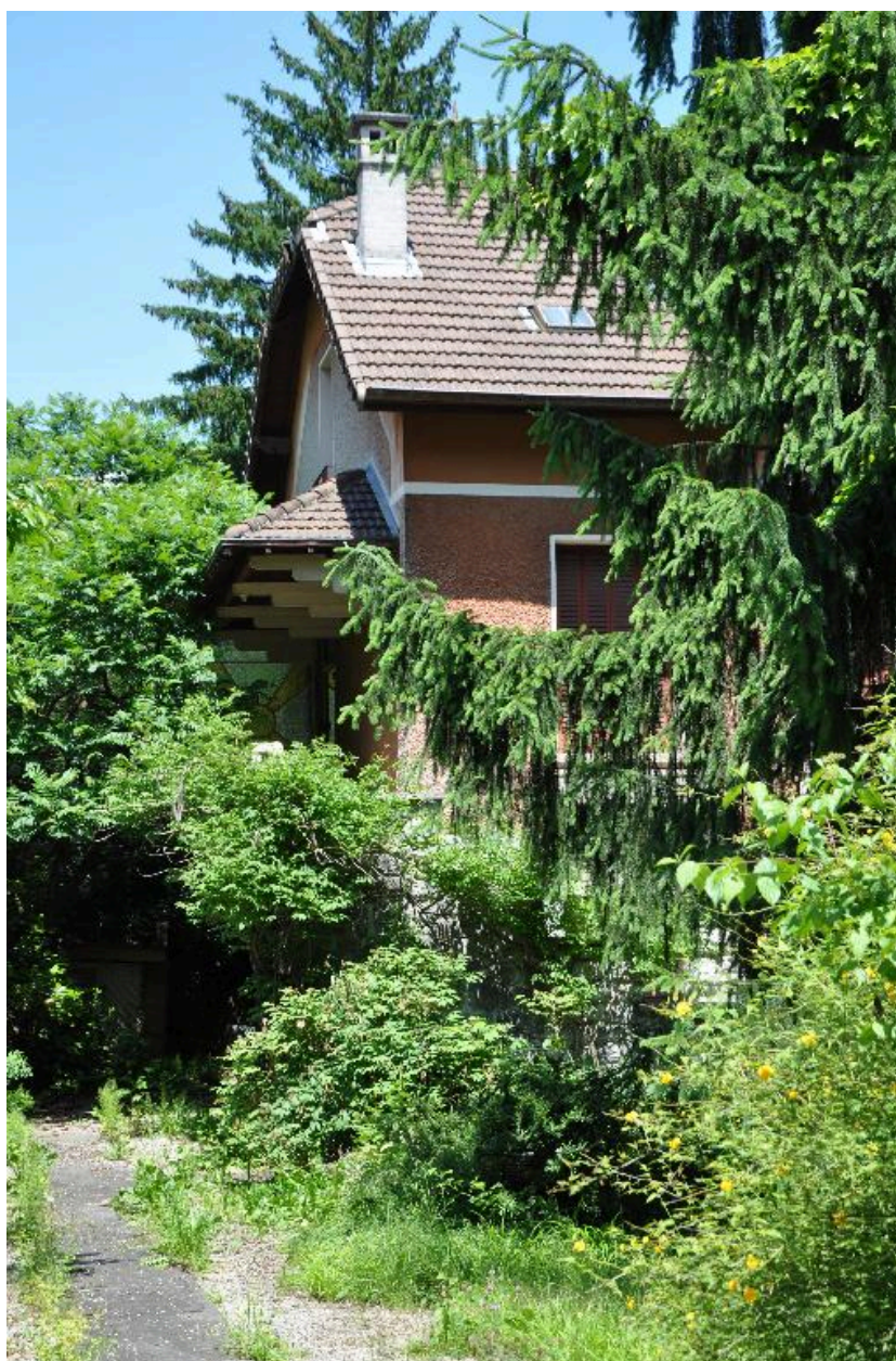
Elévation latérale et perron d'entrée
