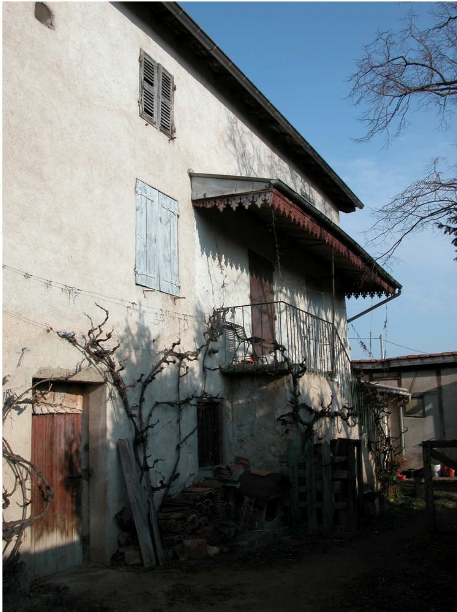
Vue d'ensemble du logis, côté cour.
