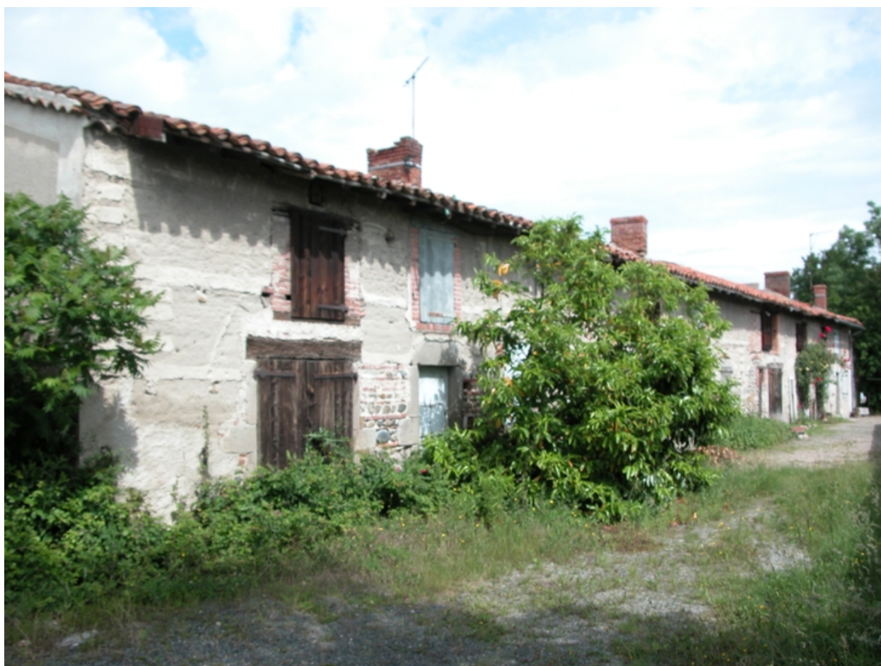
Vue générale du bâtiment ouest, depuis le sud-est.
