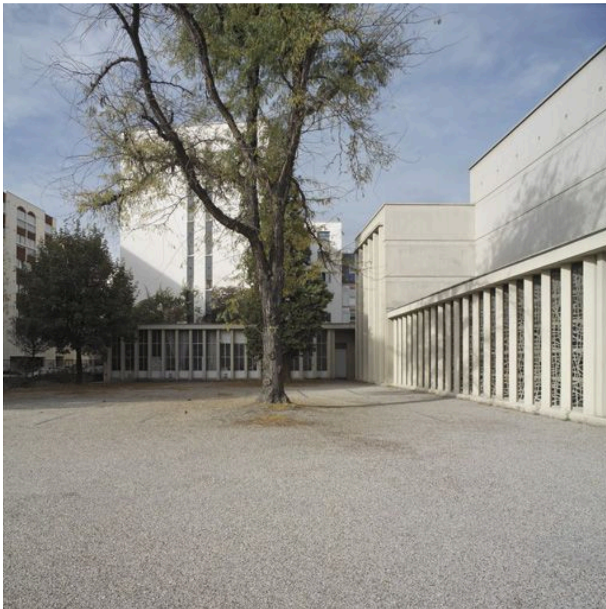
Vue d'ensemble de la cour sud depuis l'est. A droite la façade sud de l'église et au fond, un bâtiment de réunion
