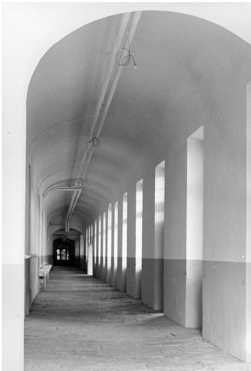
Bâtiment C. Rez-de-chaussée : galerie longeant l'église, v. 1976 (AP Plantin)
