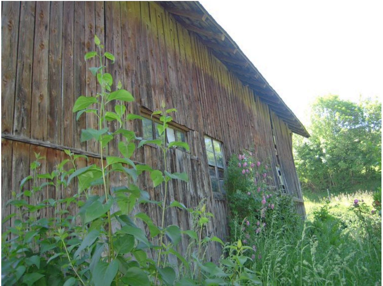
Vue de l'appentis à l'extrémité ouest du bâtiment.
