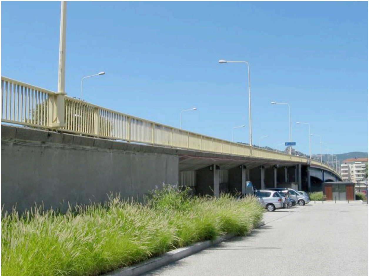
Travée de rive gauche, de côté, face amont, vue générale : accès (depuis la rive gauche)
