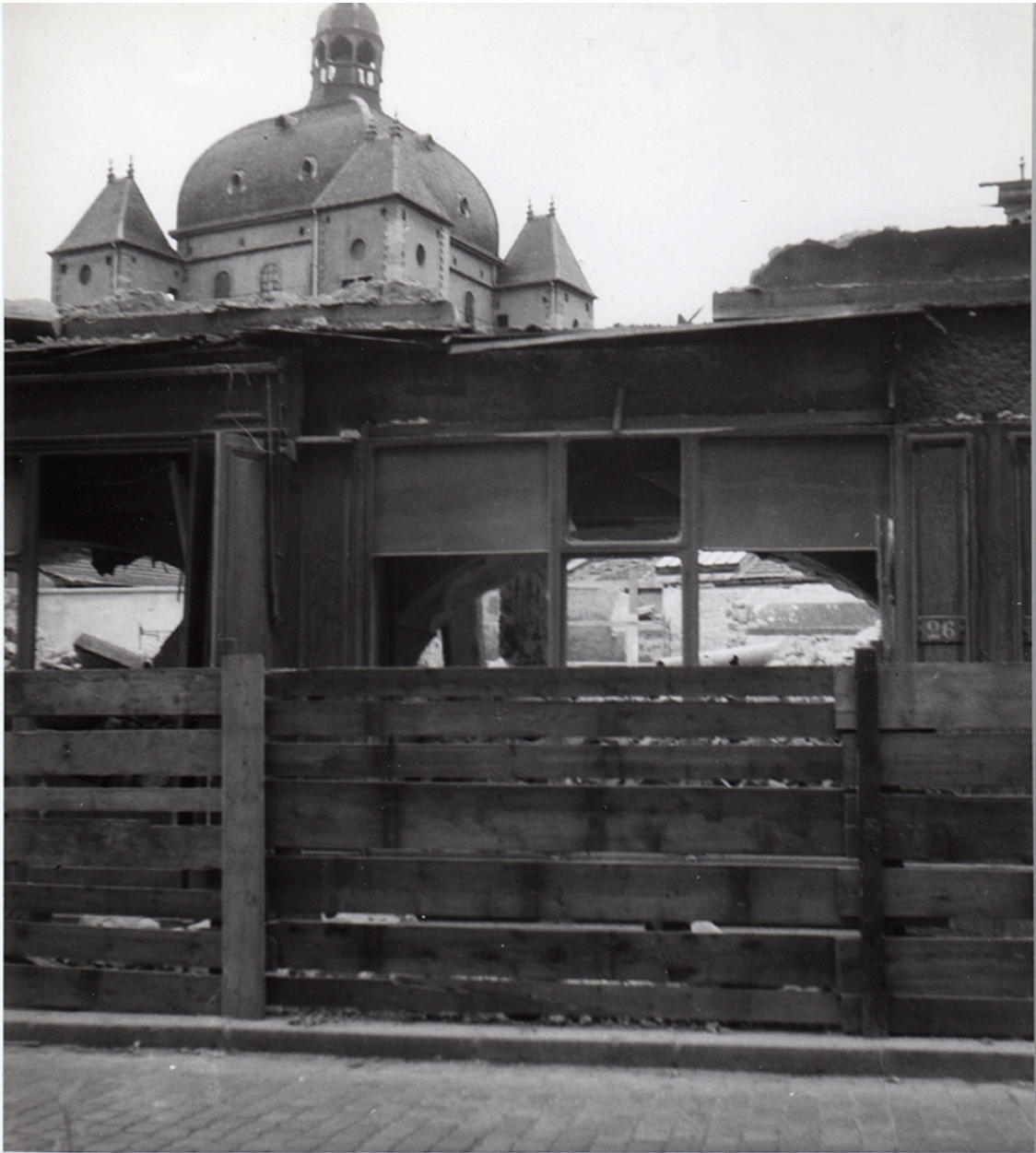
Démolition du passage, élévation rue Childebert, détail d'une devanture avec le Petit Dôme en arrière-plan
