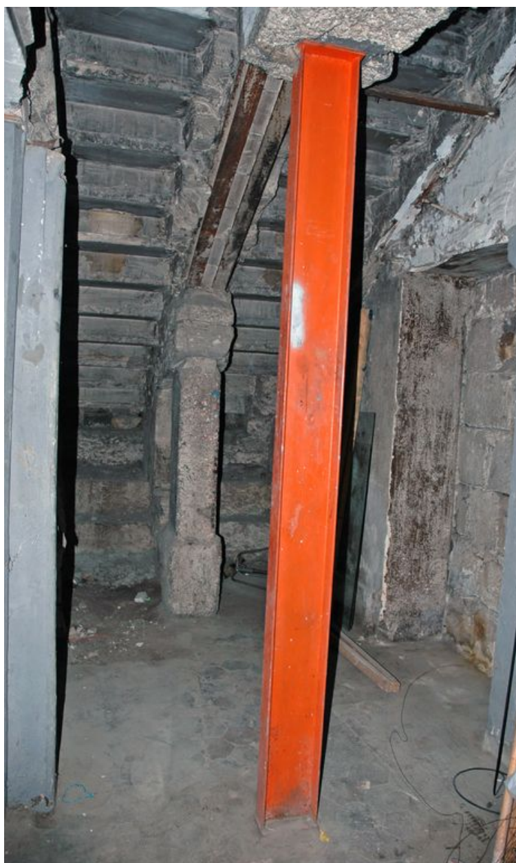
Piliers soutenant la 2e volée de l'escalier principal du corps de bâtiment nord-ouest
