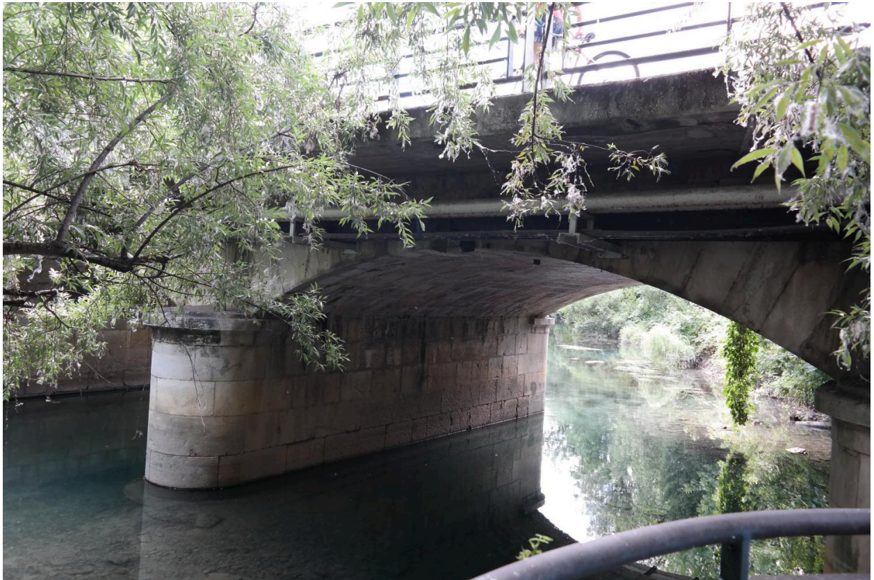
Pont Neuf, détail d'une voûte en aval
