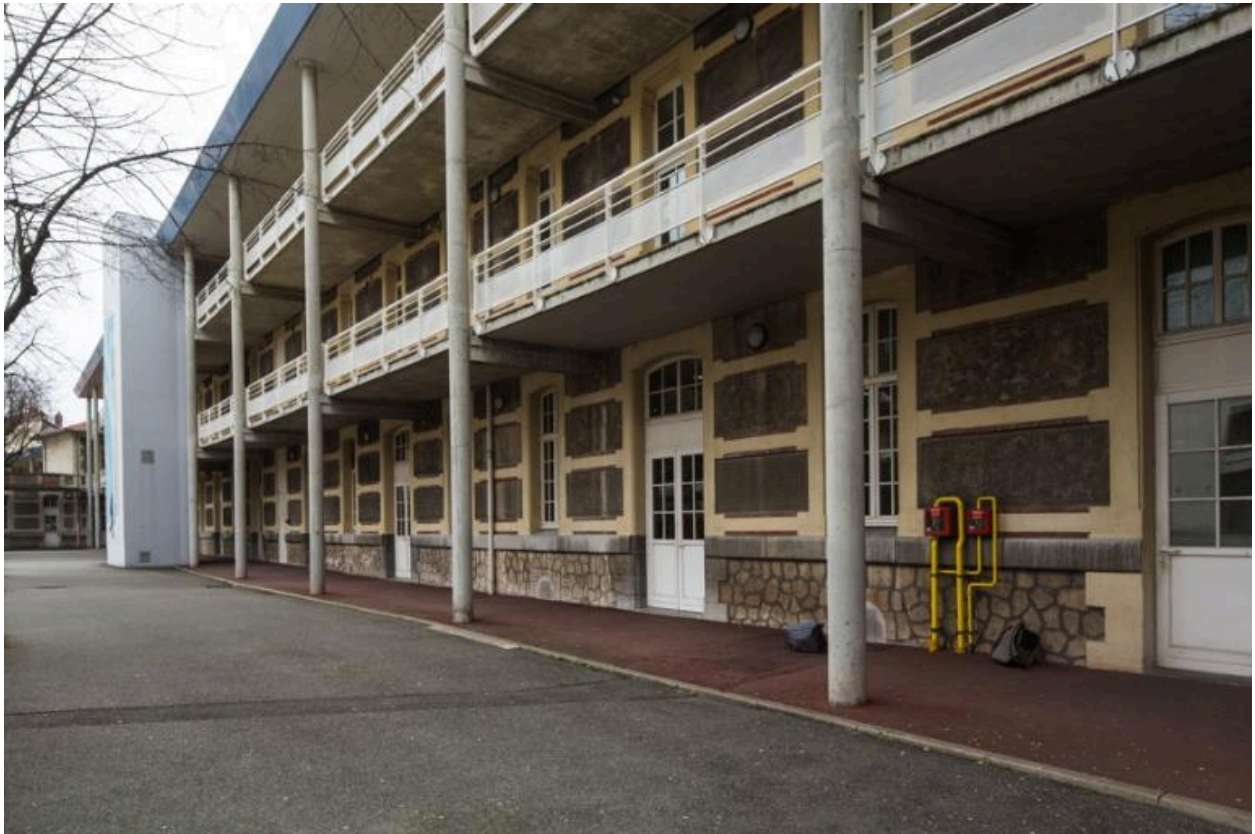
Bâtiment sud : façade nord : étage des galeries
