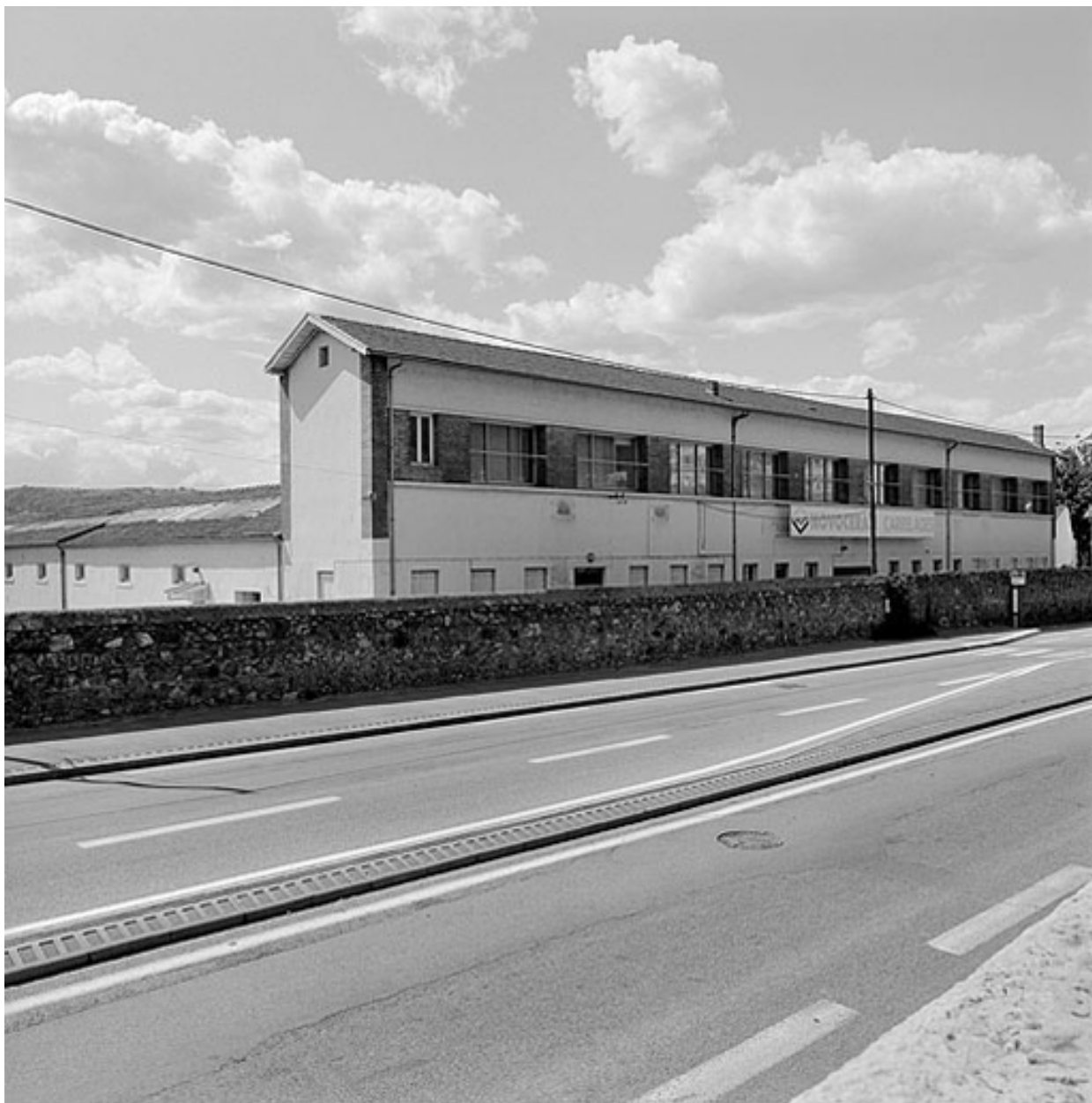
Vue d'ensemble du bâtiment principal
