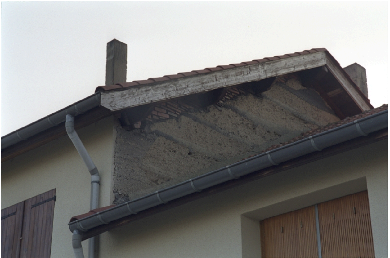
Boën, la Chaux-est, ferme (1986 AE 294). Pignon du logis.
