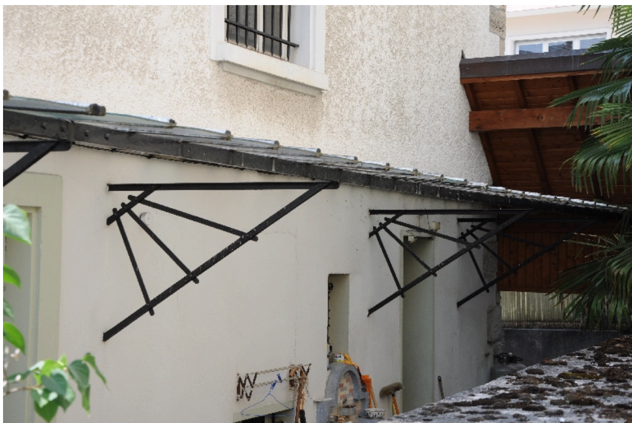
Détail de la marquise
