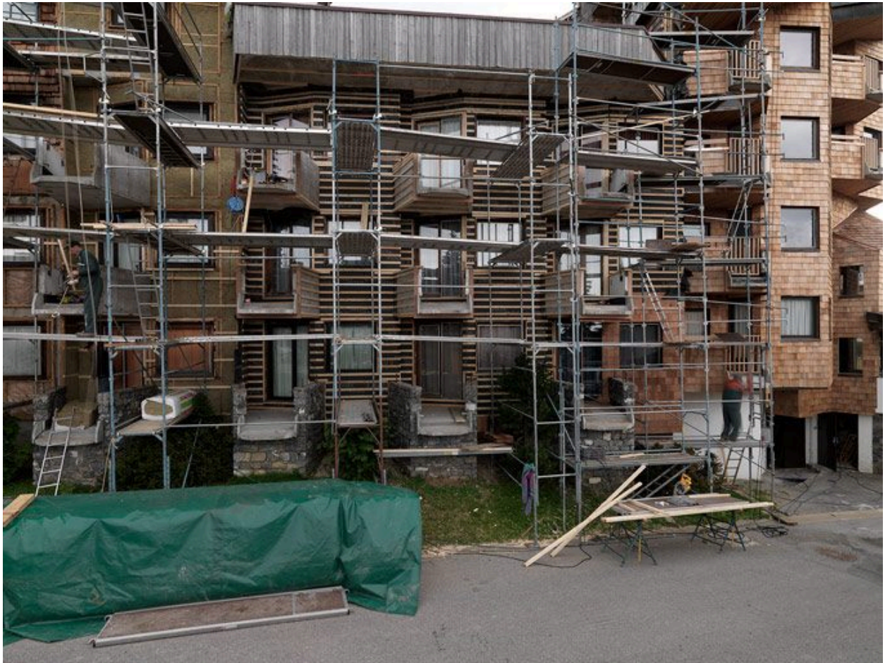
La façade en réfection
