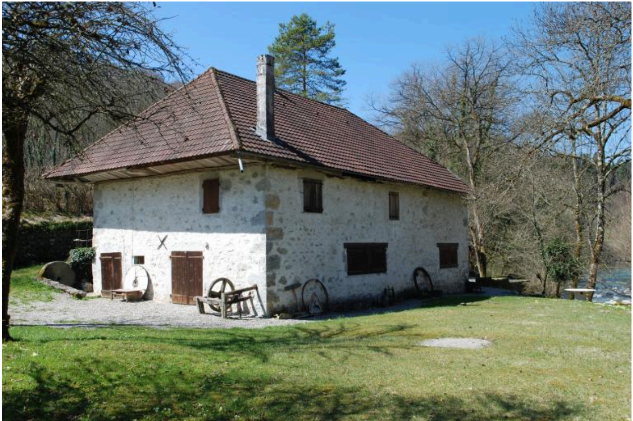
Vue d'ensemble de trois-quarts arrière gauche du moulin.
