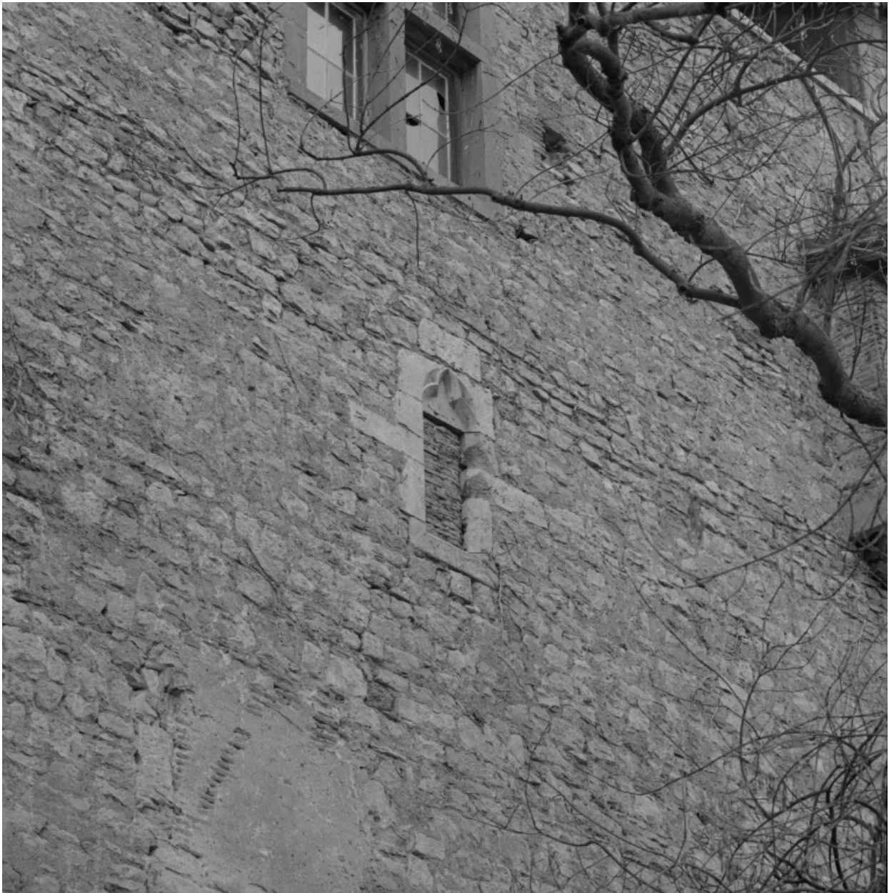
Détail de l'élévation postérieure : fenêtre gothique (linteau décoré d'un arc brisé trilobé).
